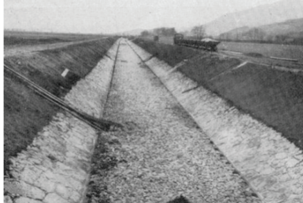
Die „neue“ Dünneren war als kahler, trapezförmiger Kanal konzipiert, Bild von Oberbuchsiten.
